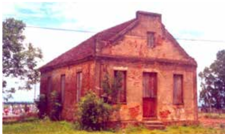
A antiga residência do professor da sociedade escolar de Lagoa dos Três Cantos. Infelizmente a construção histórica foi demolida. Ao fundo, o cemitério da Comunidade Luterana e católica. (Foto: Edio - 1998)
